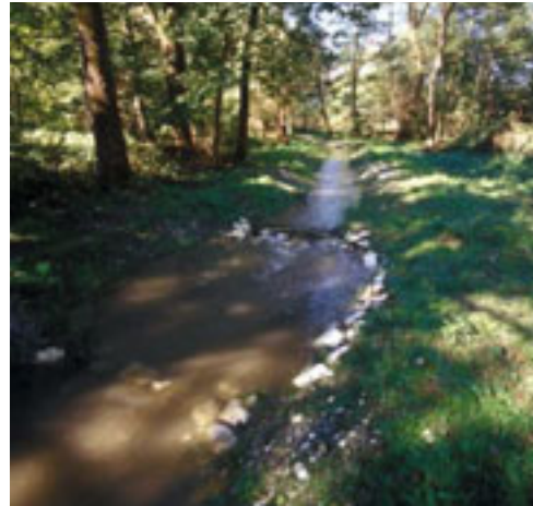
Fig. 13 – Il fossato/canale dopo i lavori (foto: G. Stefani).
